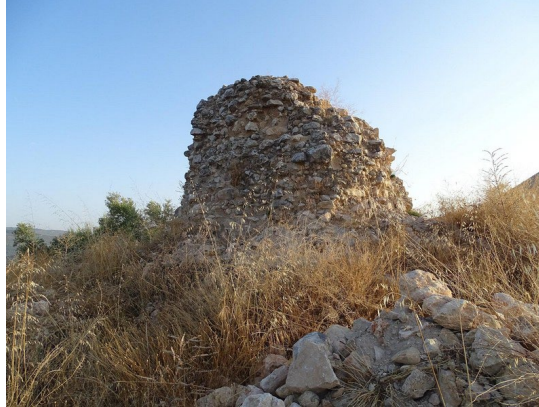
Figure. 1. Torre de la Gallina (Moclín, Spain)
